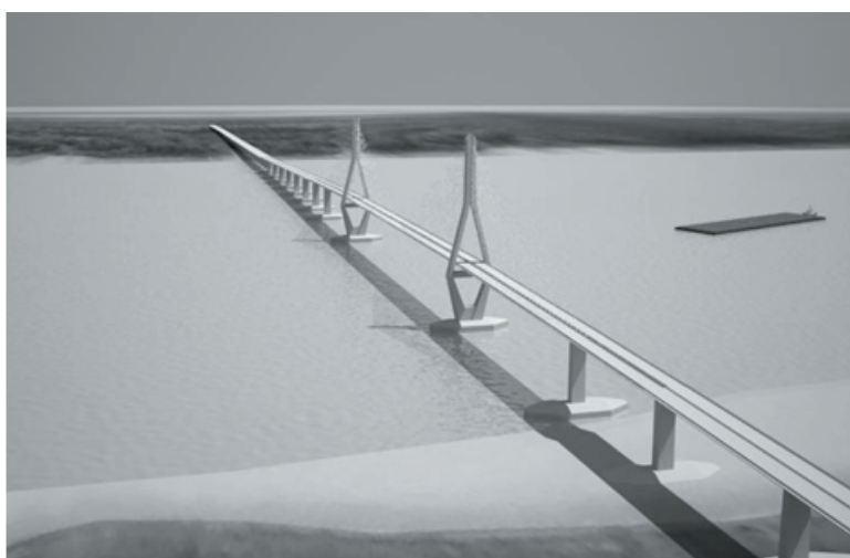
Figura 3. Imagen del Puente Principal
