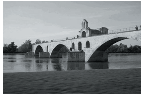
Figura 3: Puente de Avignon
