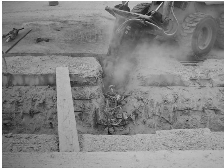
Figura 6. Demolición de la dovela 15
