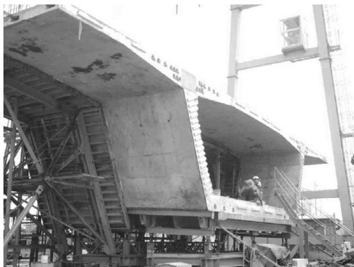
Figura 4. Dovela premoldeada pretensada
