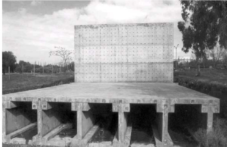
Figura 5 - Fin de construcción para Losa de Anclaje y del Muro Reactivo. Año 1999.
