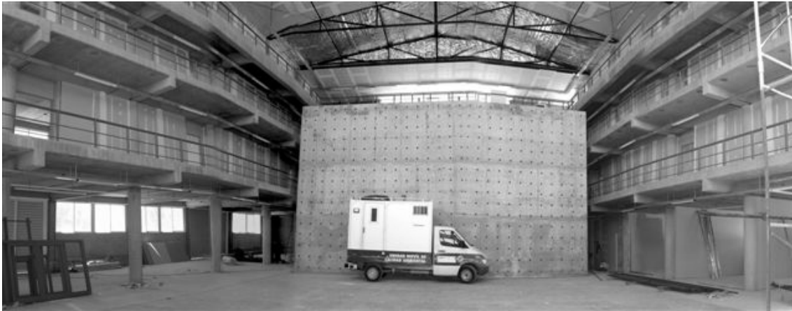
Fig. 8. Vista desde el nivel 0.00 del hall Central.
